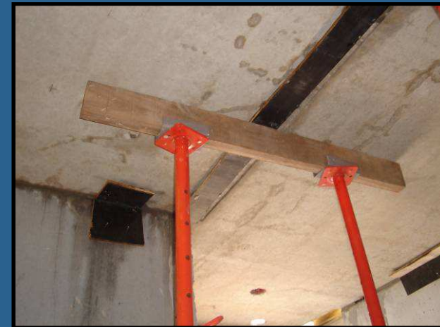
Escora tripé dupla - região de emenda entre pré-lajes
