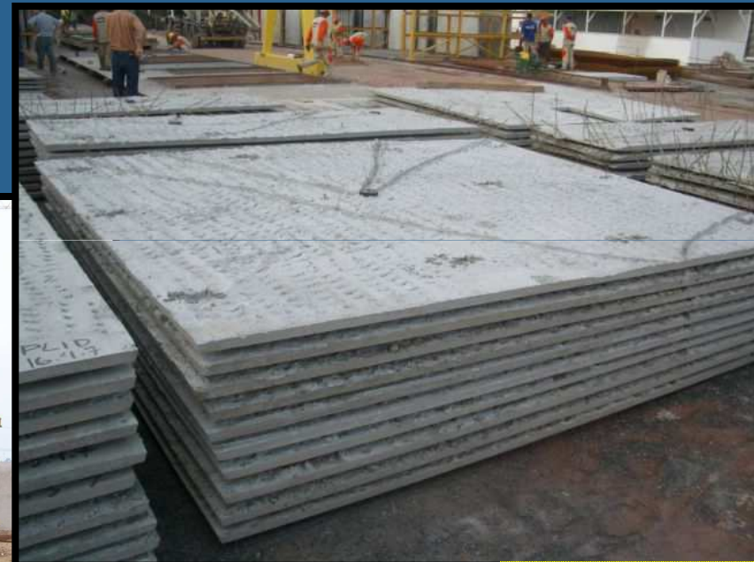
Estoque das pré-lajes
